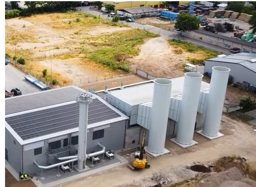
Heidelberg 4 MW (rechter Teil) Quelle: Stadtwerke Heidelberg
